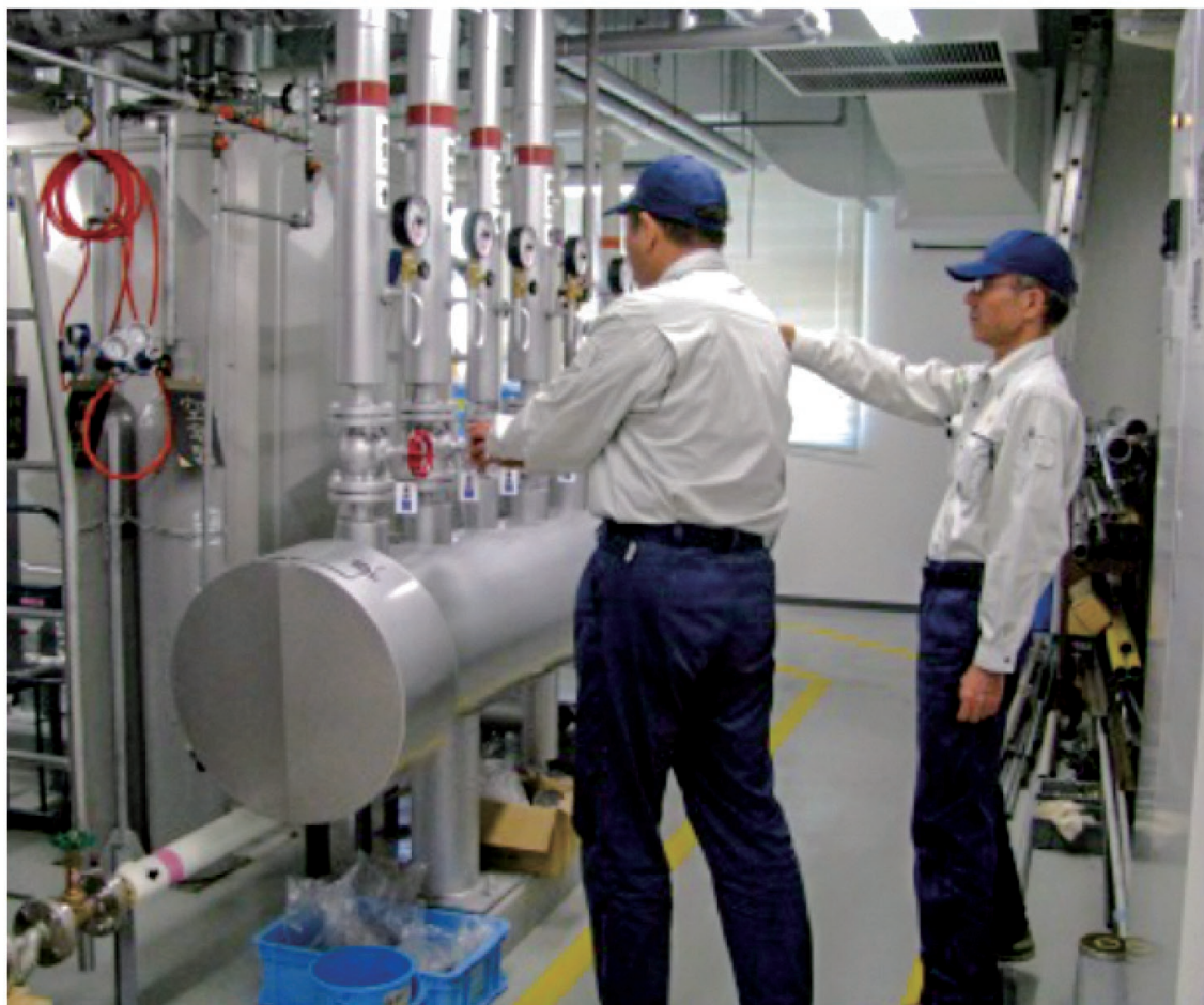
蒸気ヘッダー操作実習
