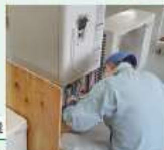
給湯器取付け作業
