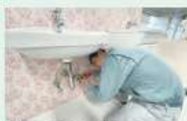
衛生器具取付け作業
