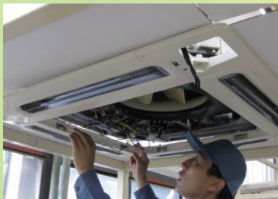
業務用エアコン取付
