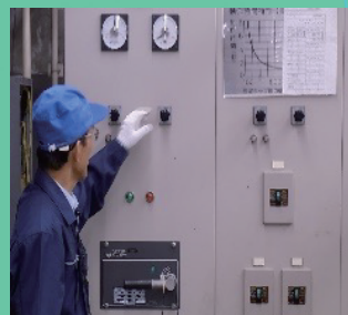
受変電設備作業
