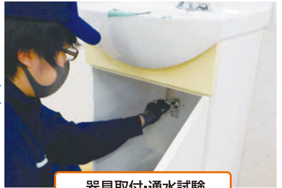
器具取付・通水試験
