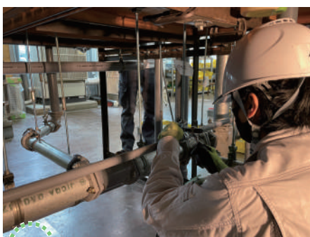
給排水配管の施工
