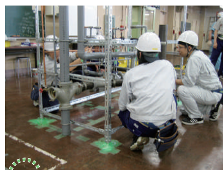
給排水配管の施工
