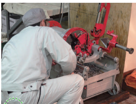
給排水配管の施工
