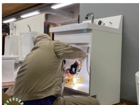
衛生器具の取付け
