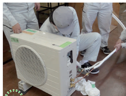
エアコンの取付け
