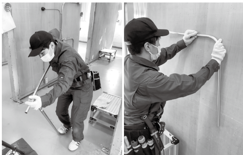
金属管工事の実技。繰り返し手を動かし、技能を身につけていく。
